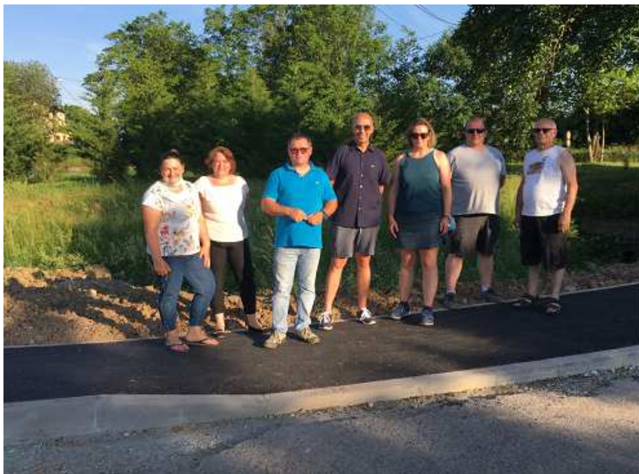
Les conseillers visitent le chantier du Quartier de la Gare
